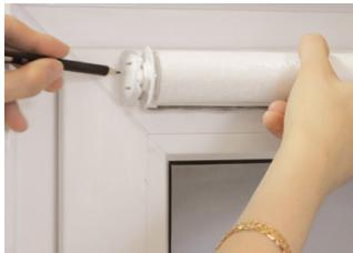
1. Приложите карниз жалюзи строго горизонтально к оконной раме и в местах крепления кронштейнов сделайте отметки с обоих сторон карниза.
