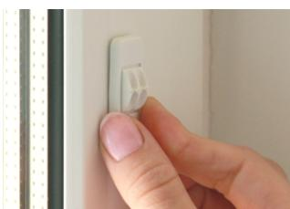
6. Прикрутите фиксатор цепочки к раме на необходимой высоте. После того, как отрегулируете жалюзи, зафиксируйте там цепочку управления.
