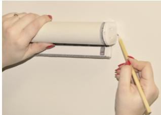
1. Приложите карниз жалюзи строго горизонтально к стене и в местах крепления кронштейнов сделайте отметки с обоих сторон карниза.
