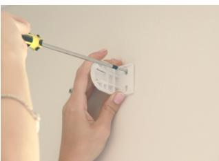
4. Через монтажные отверстия прикрутите кронштейны к стене при помощи саморезов.
